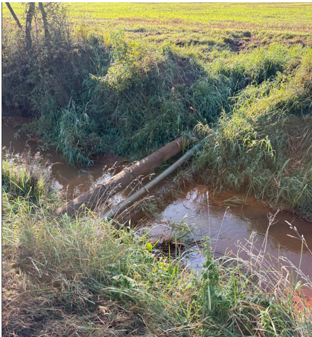
Fig. 4. Eksisterende krydsning af Hillerup-Tanderup Bæk med vandleddning, der fjernes og brinkerne retableres.
